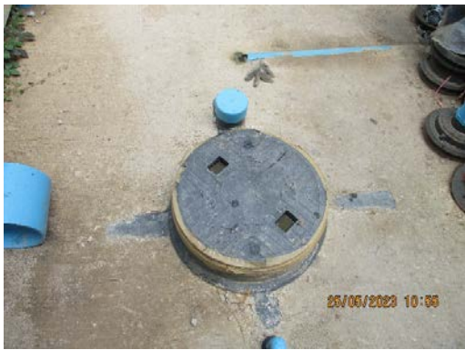
รูปที่ 15 ถังสำรองน้ำระบบบำบัดน้ำเสีย
